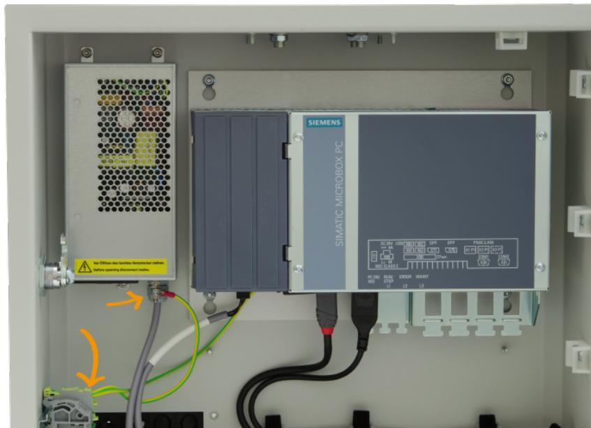
5. Verlegen Sie das 24V Ausgangskabel der Netzteilkassette durch die Kabelhalterungen zur Front hin. Schließen Sie den grünen Stecker dort an eine der grünen 24V - Buchsen an (X111 oder X112).
